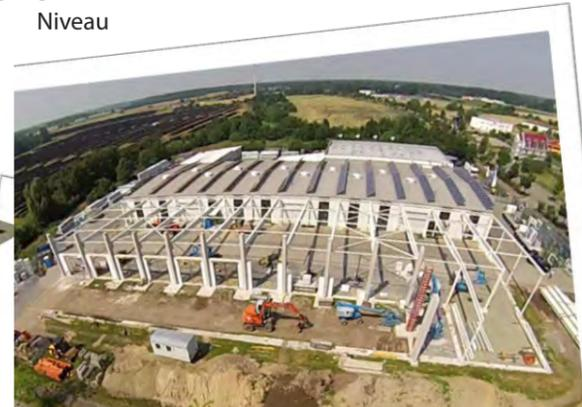
Die Stahlkonstruktionen bestehen aus Stahlblechträgern mit einer Spannweite von 24 m. Die Lagerhalle ist längsseitig an einer Produktionshalle angedockt.
