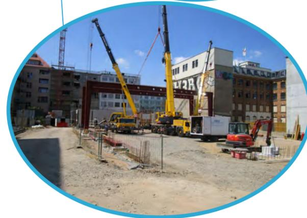
In Leipzig laufen unsere Arbeiten zum "Rahn-Campus". Highlight ist sicher der geplante Sportplatz auf dem Dach der Sporthalle sowie die Nutzung der Dachfläche des Verbindungsbaus als Schulhof. Die Hallenkonstruktion besteht aus mehreren Stahlrahmen mit einer Stahlbetondecke als Dach. Der Hallenbinder soll durch Kopfbolzen mit der Stahlbetondecke verbunden werden (Verbundbauweise).
