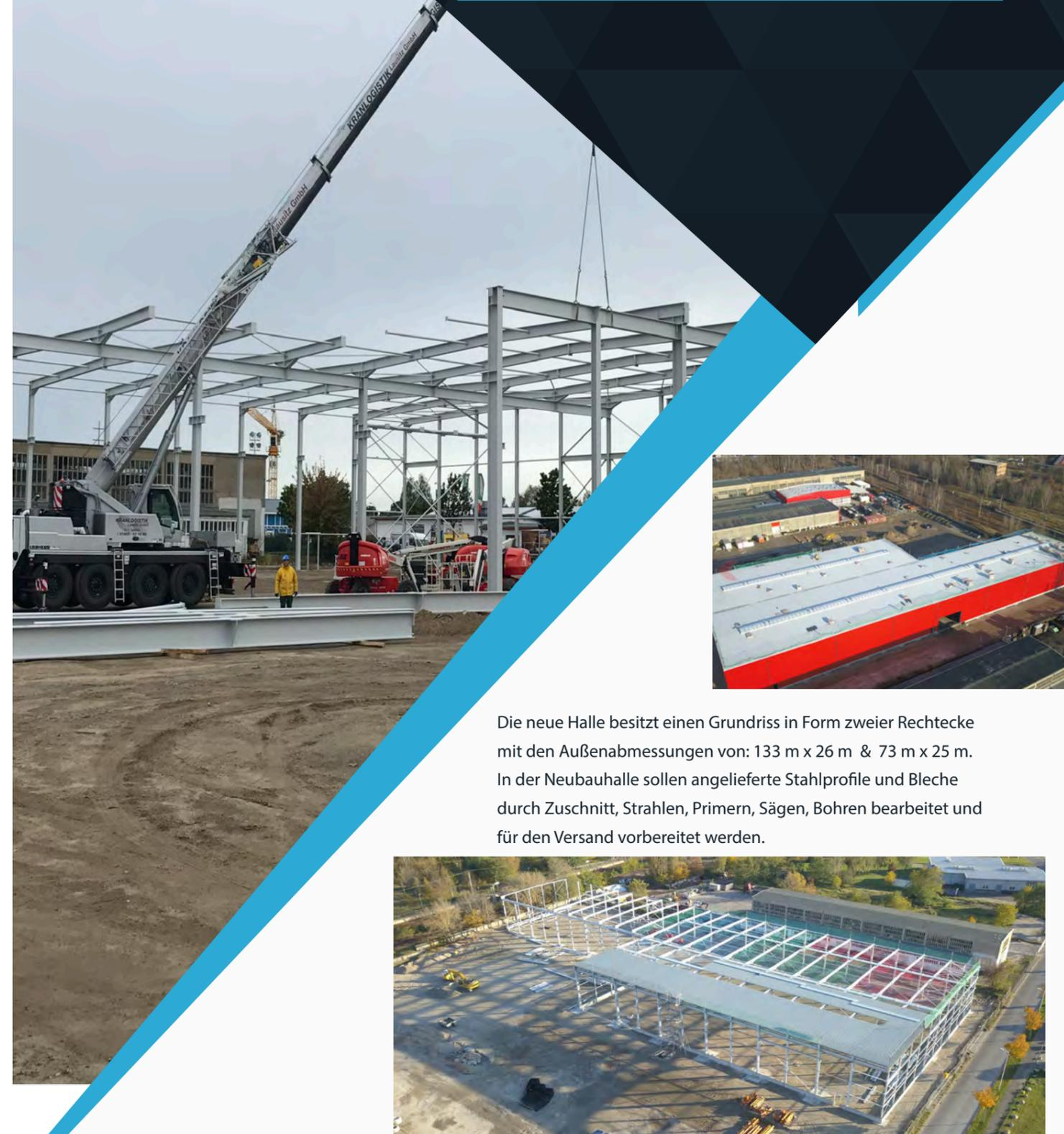
Die neue Halle besitzt einen Grundriss in Form zweier Rechtecke mit den Außenabmessungen von: 133 m x 26 m & 73 m x 25 m. In der Neubauhalle sollen angelieferte Stahlprofile und Bleche durch Zuschnitt, Strahlen, Primern, Sägen, Bohren bearbeitet und für den Versand vorbereitet werden.
